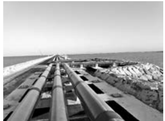
شکل ۱ - خطوط لوله GRE شرکت نوین کامپوزیت - اسکله حرا قشم
