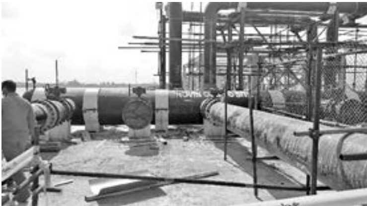
شکل ۱ - خطوط لوله GRE شرکت نوین کامپوزیت - اسکله حرا قشم
