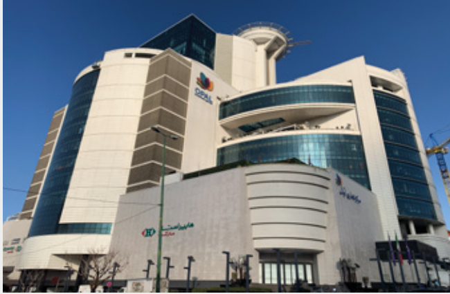
[ مرکز خرید آپال - سعادت آباد ] تفکیک برق و آب واحدهای تجاری
