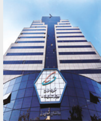
[ ساختمان مرکزی همراه اول ] مدیریت اندازه گیری برق واحدهای اداری تعداد کنتورهای برق: ۱۶۱ کنتور
