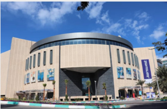
[ مجتمع تجاری / تفریحی میکامل - کیش ] تفکیک برق مصرفی و سرمایه‌ش چیلر واحدهای تجاری ۱۴۵۷ دستگاه
